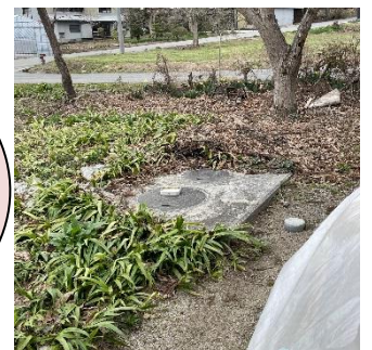
建物北面に浄化槽
