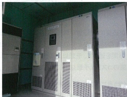
図4●パワーコンディショナー(PCS)は東芝三菱電機産業システム(TMEIC)製を採用(出所:日経BP)
