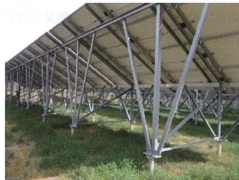
図7●「長井第2おひさま発電所」は設置角30度、設置高1.8mにした(出所:日経BP)
