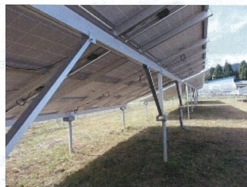
図3●雪対策に設置角20度、設置高1.5mに設置した(出所:日経BP)
