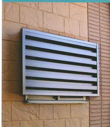
施工後（SPA型）
