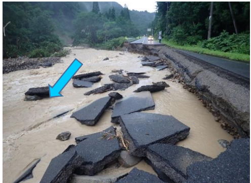
被災状況①
