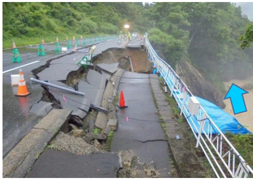
被災状況②
