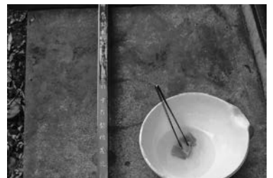
⑦錆びつけ用の溶液を塗布して黒錆を発生させる作業
